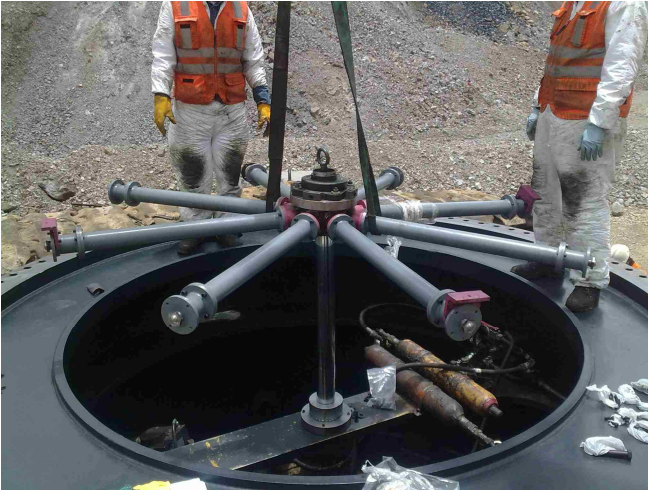
Fuente: 11032010849.JPG Instalación soporte superior
